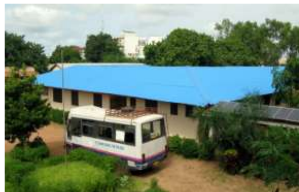
Het nieuwe dak
